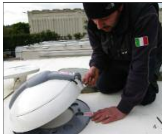
A sinistra, il facile smontaggio dell'unità dalla sua base. Sotto, una volta terminata l'installazione si verifica il corretto funzionamento dell'antenna sintonizzando un canale televisivo.
